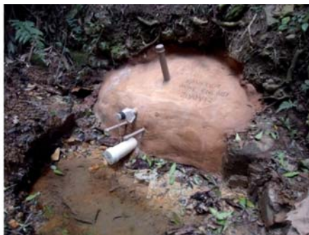
Figuras 27 e 28 - Trabalho de proteção de nascente realizado na propriedade do Sr. Bráulio Soares de Melo - Município de Tomazina-PR, (aspecto antes e depois)
