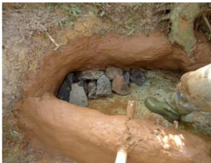
Figura 26 - Aspecto da proteção concluída, observando-se os canos devidamente fechados
