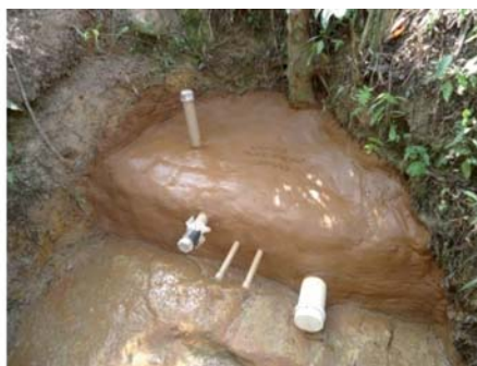
Figuras 31 e 32 - Trabalho de proteção de nascente realizado na propriedade do Sr. José Pedro dos Reis Filho - Município de Tomazina-PR, (aspecto antes e depois)
