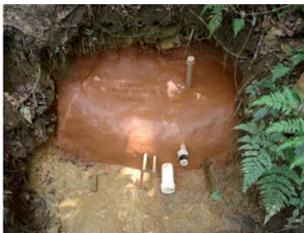
Figuras 33 e 34 - Trabalho de proteção de nascente realizado na propriedade do Sr. Cristiano Daniel da Silva - Município de Tomazina-PR, (aspecto antes e depois)
