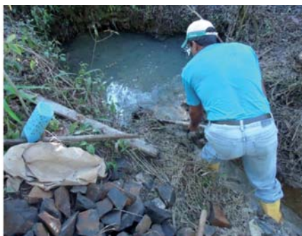
Figura 6 - Abertura de vala de escoamento
