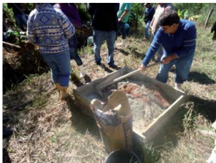
Figura 9 - Mistura de terra com cimento
