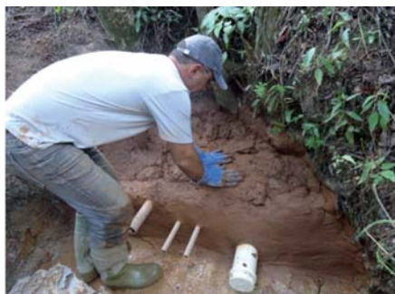
Figura 24 - Fechamento da nascente com a massa de solo-cimento
