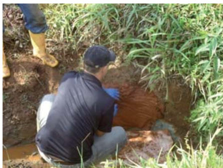
Figura 13 - Reboco das paredes do barranco
