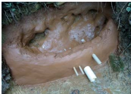
Figura 21 - Aspecto da nascente antes da colocação das pedras
