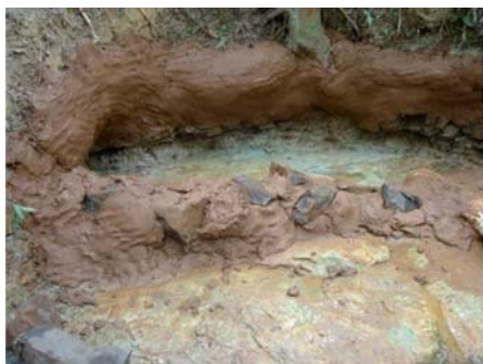
Figura 15 - Aspecto da barragem, observando-se as pedras unidas pela massa de solo-cimento
