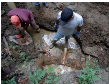
Figura 16 - Construção da barragem no momento da colocação do cano de esgotamento
