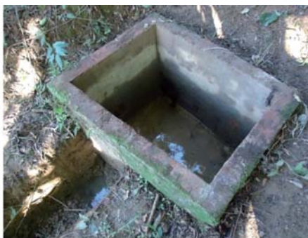
Figura 4 - Nascente com estrutura passível de ser aproveitada
