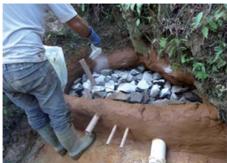
Figura 23 - Cal hidratada sendo esparramado sobre as pedras
