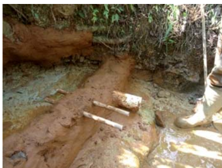
Figura 17 - Assentamento dos canos de abastecimento
