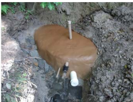
Figuras 35 e 36 - Trabalho de proteção de nascente realizado na propriedade do Sr. Dalmiro Lopes Marçal - Município de Tomazina-PR, (aspecto antes e depois)
