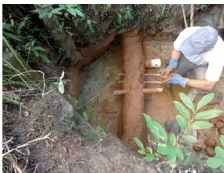
Figura 18 - Assentamento do cano ladrão
