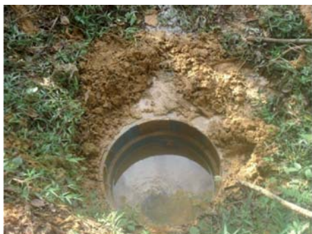
Figura 3 - Nascente com estrutura pré-existente, que deve ser retirada
