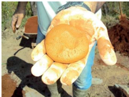
Figura 11 - Consistência adequada da massa
