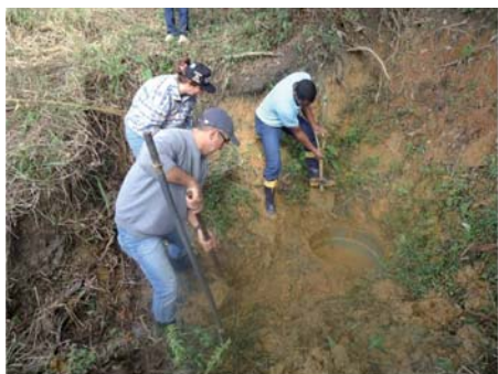
Figura 5 - Retirada de estrutura pré-existente e início de abertura de vala de escoamento
