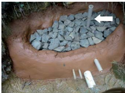
Figura 22 - Nascente preenchida com pedras. Observar o assentamento do cano suspiro (seta)
